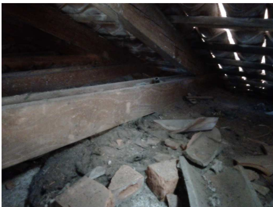
FOTO III – DETTAGLIO PUNTONI E CATENE
